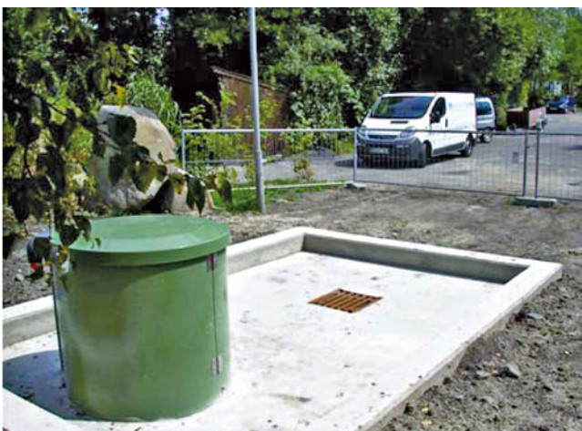
Abb. 2: Unterirdischer Tank am Pumpwerk mit WHG-konformer Auffangwanne
