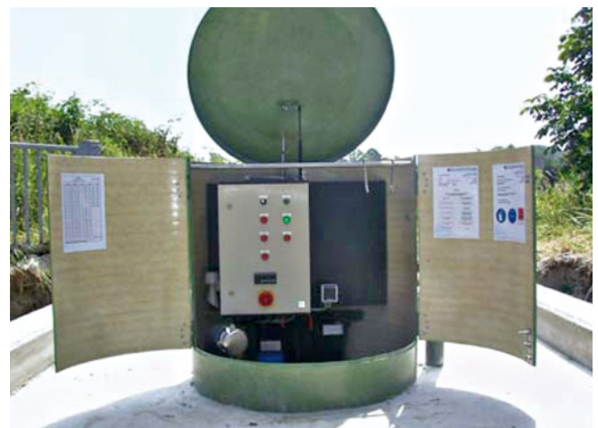
Abb. 3: Dosieranlage im Domschacht
