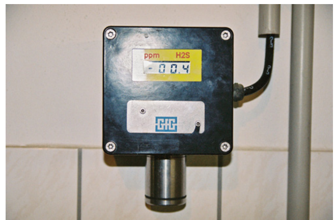
Abb. 8: Kontinuierliche Messwerterfassung mittels eines H 2 S-Sensors im Sandfanggebäude. Verarbeitung des Messsignals und Ansteuerung der KRONOFLOC Dosierpumpen. Die Ergebnisse sind in der Abb. 10 grafisch dargestellt.
