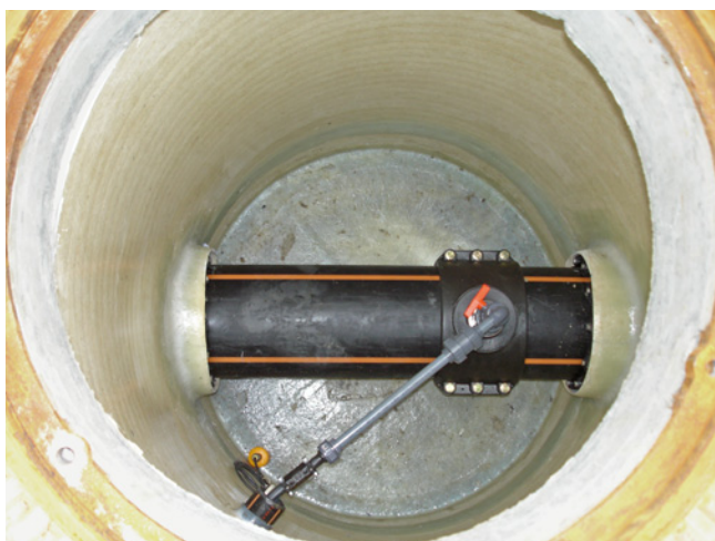
Abb. 5: Dosierung über Anbohrschelle direkt auf die Druckleitung
