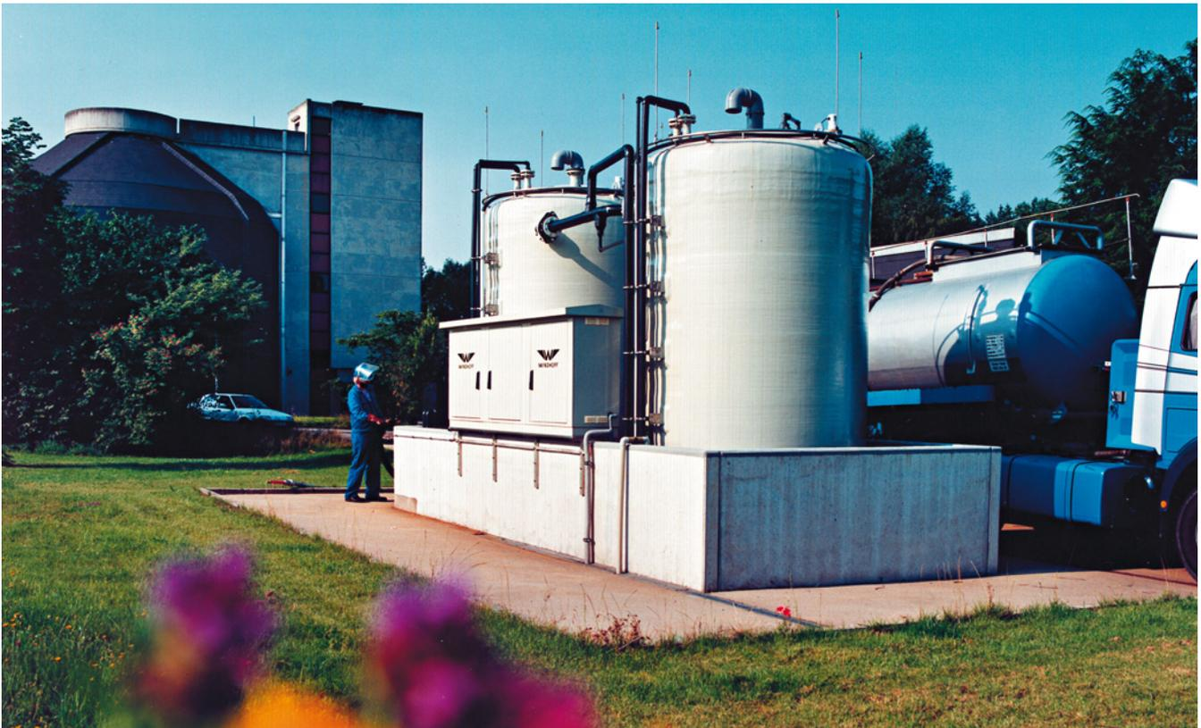
Abbildung 3: Lager- und Dosierstation
